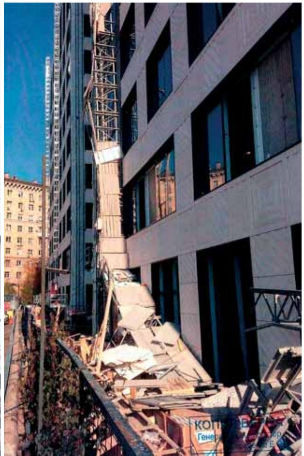
**Рис. 61, а, б, в.** Деформация платформы и падение мачтового строительного подъемника с рабочей платформой модели ISIS-132 на объекте строительства офисно-административного комплекса в г. Москва
