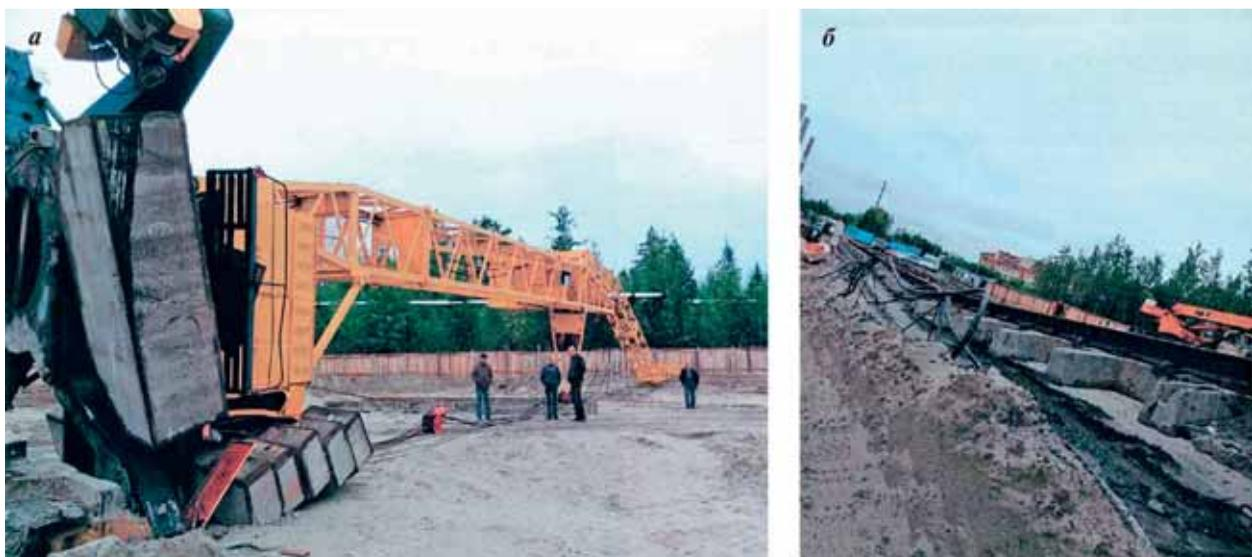
Рис. 54, а, б. Падение башенного крана КБ-309ХЛ на строительной площадке в г. Нягань
