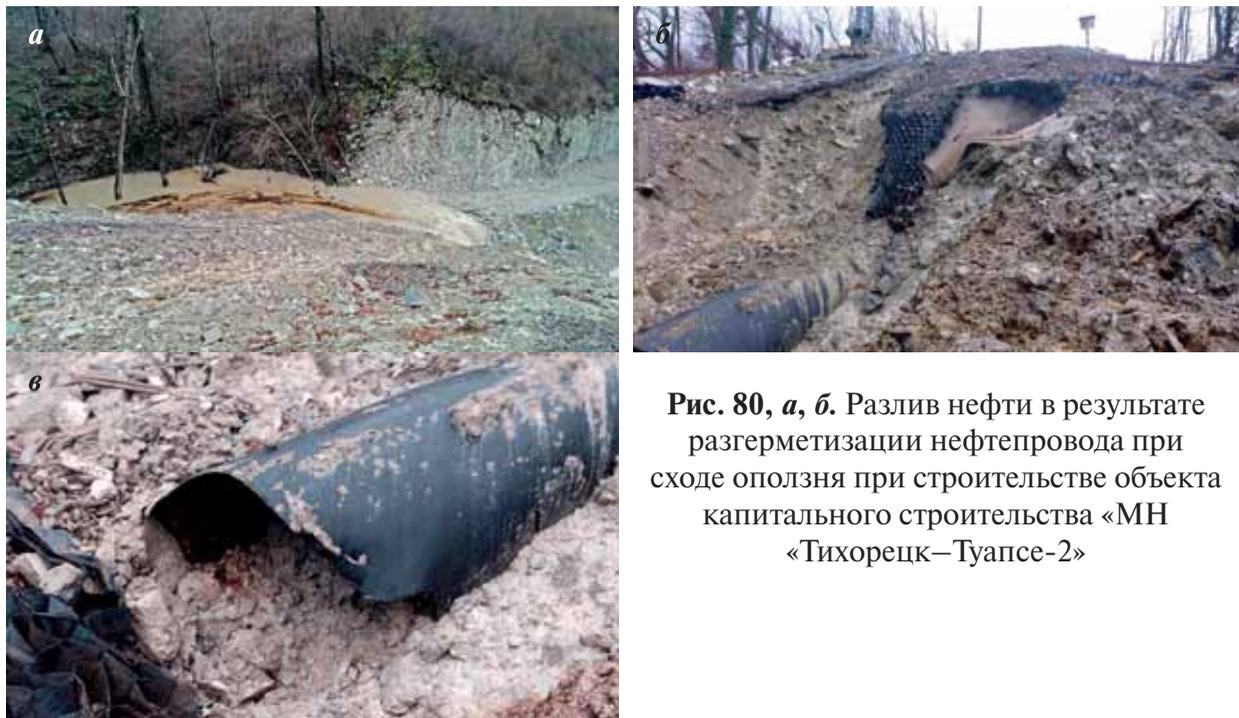
**Рис. 80, а, б.** Разлив нефти в результате разгерметизации нефтепровода при сходе оползня при строительстве объекта капитального строительства «МН «Тихорецк—Туапсе-2»
