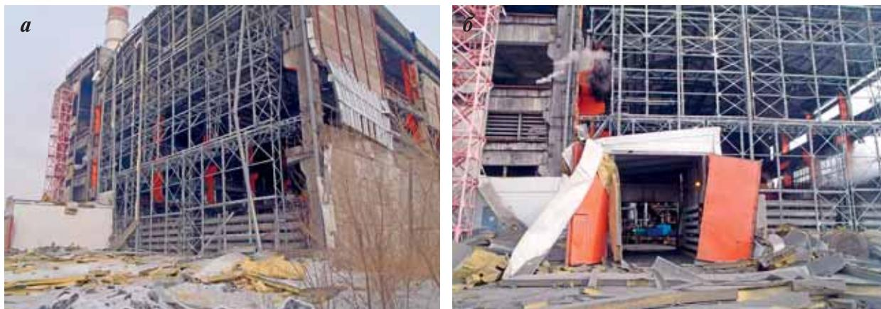
**Рис. 33, а, б.** Разрушения от взрыва, происшедшего при растопке парового котла типа ТП-87 в главном корпусе Западно-Сибирской ТЭЦ — филиала ОАО «ЕВРАЗ ЗСМК»
